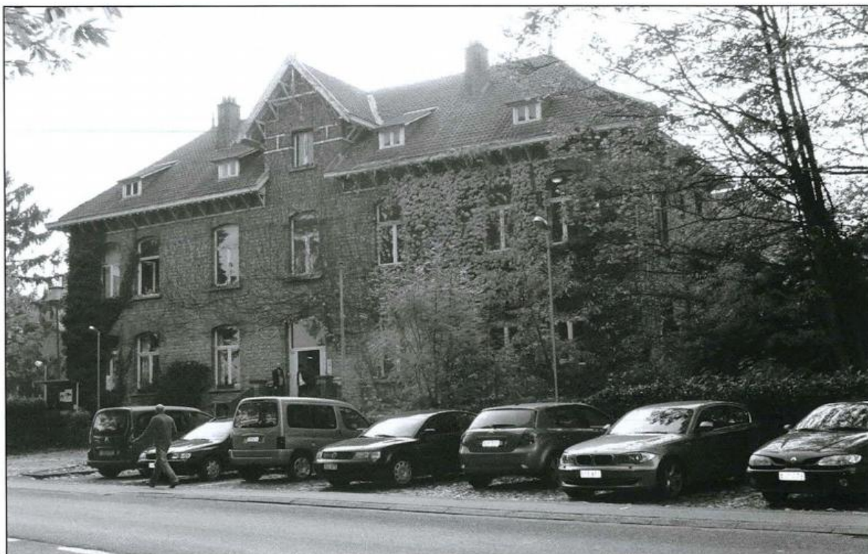
Het gebouw in de huidige toestand. Thans doet het dienst als asielcentrum en wordt uitgebaat door "Het Rode Kruis van België".
